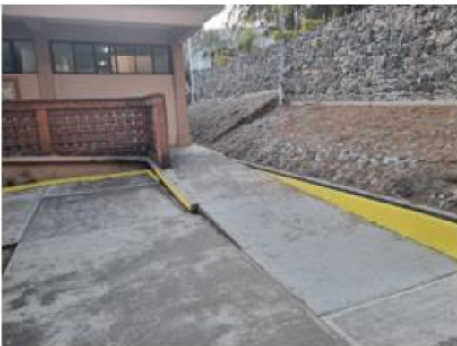
FRENTE A BAÑOS DE EDIF. 31
